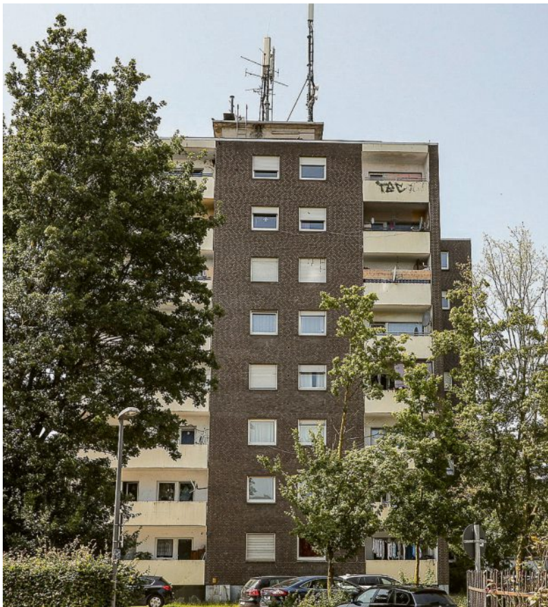
Der Achtstock steht in einer eher von Einfamilienhäusern geprägten Siedlung in Rhede.
