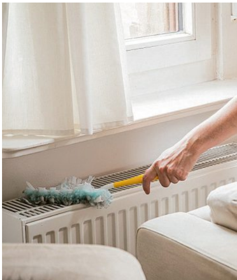
Saubere Heizkörper: Staub und Schmutz mindern die Wärmeabgabe und sollten regelmäßig entfernt werden. FOTO: CHRISTIN KLOSE/DPA-TMM
